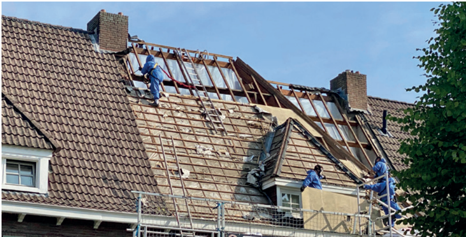
Entfernen von Asbest für ein neues Dach
