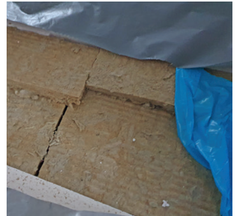
Mineralische Dämmung unterhalb einer Rauchschutztür (Brandschutz)
