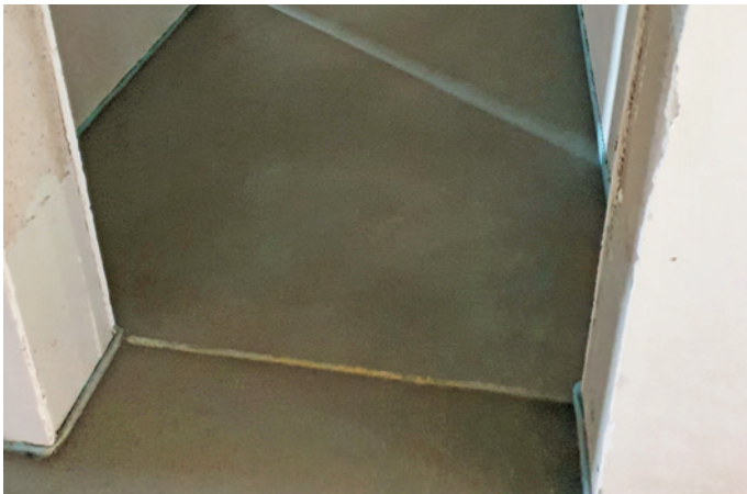
Frisch verlegter Zementestrich – Fugen unterhalb der Türöffnung
