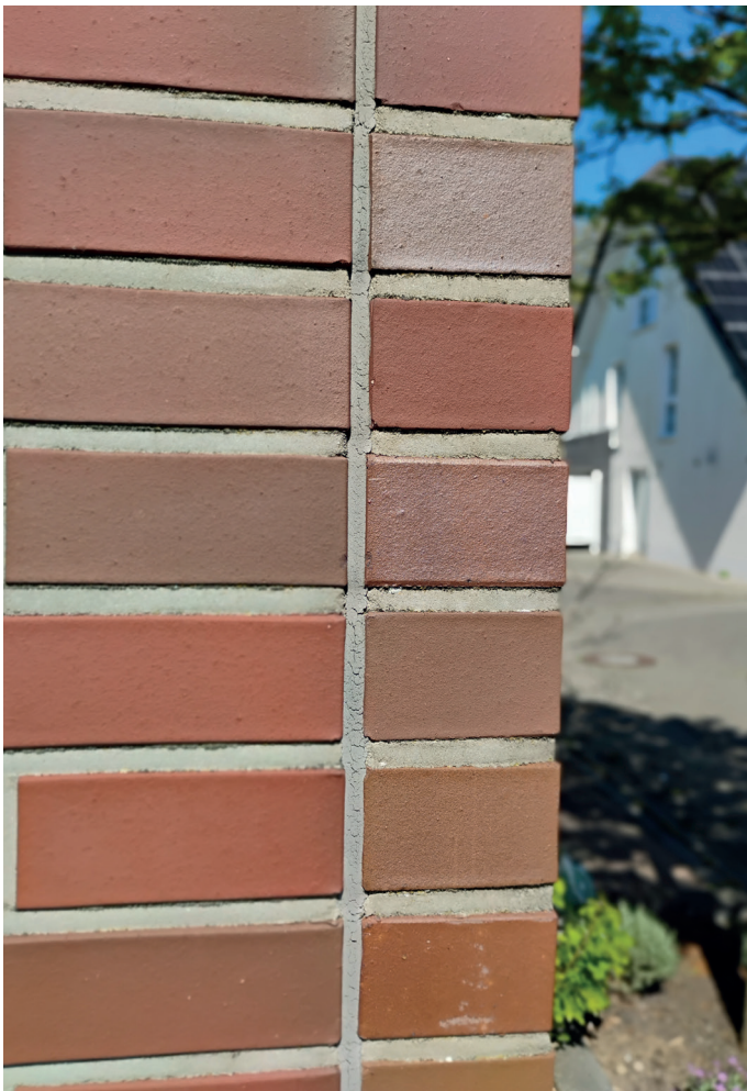
Klinkerfassade mit Eckfuge ohne Risse
