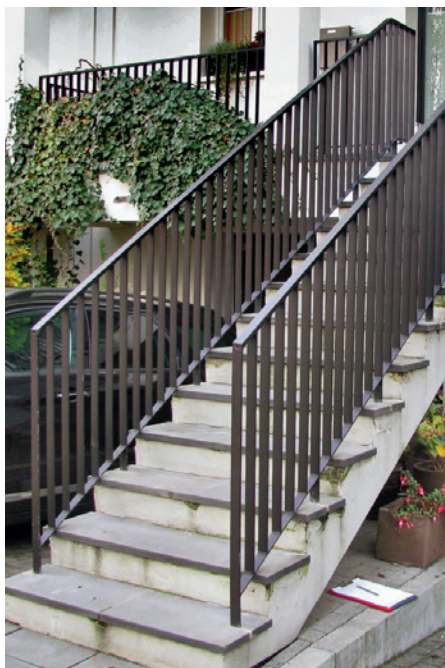
Verschmutzung/Vermoosung der verputzten Setzstufen und Treppenwange
