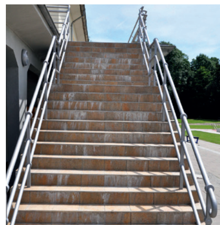
Stufenanlage mit Kalkausblühungen auf dem Fliesenbelag
