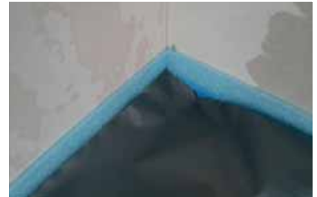
Estrichrandstreifen und Schrenzlage
