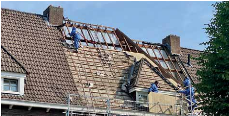
Entfernen von Asbest für ein neues Dach
