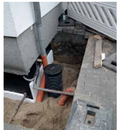
Drainagespülschacht
