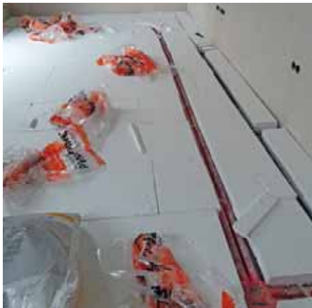
Trittschalldämmung
