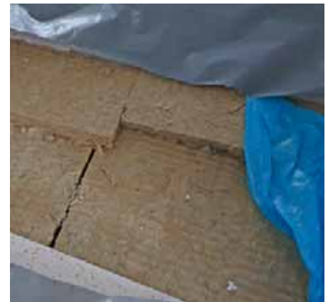
Mineralische Dämmung unterhalb einer Rauchschutztür (Brandschutz)
