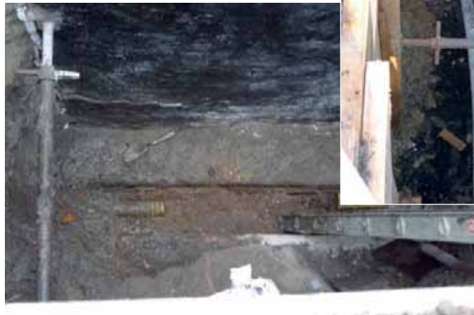
Ummantelte Felddrainage
