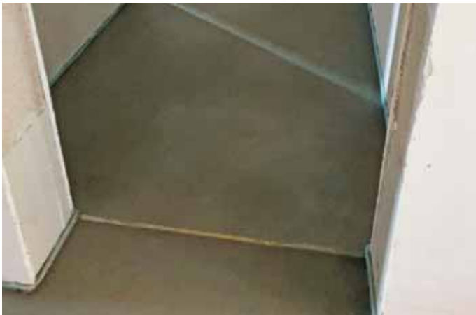
Frisch verlegter Zementestrich – Fugen unterhalb der Türöffnung
